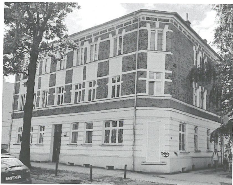
Fot.2 Budynek przy ul. Jesionowej 6, rok 2023
